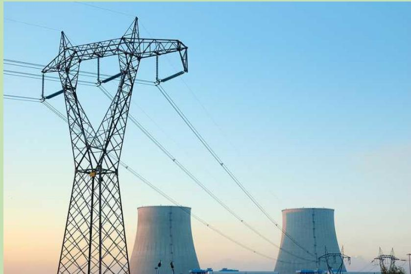
Struja se pušta kroz transformatore da joj se poveća napon, zbog dostavljanja na velike udaljenosti. Struja prolazi dalekovodom visokog napona, koji pokriva celu državu. Uz pomoć njih, struja se tako transportuje uz minimalni gubitak. U podstanici, gde se ukrstaju dalekovodi, napon se smanjuje i struja se kroz mrežu nižeg napona dostavlja potrošačima. Nakon toga, transformatori dodatno smanjuju napon, da bismo bezbedno mogli da koristimo struju u svojim domovima. (Ádám Béla [2011])
